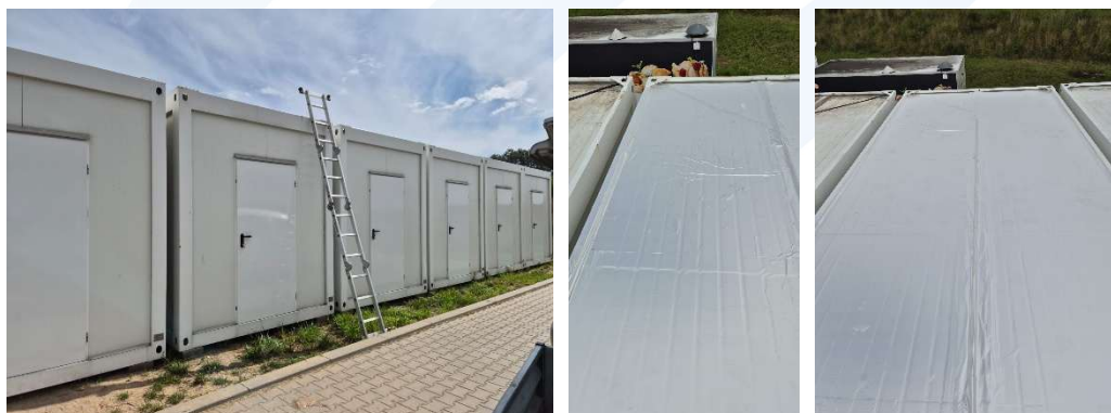
Rysunek 3. Zdjęcia obiektu badawczego w czasie instalacji membrany chłodzącej Radi-Cool FR5S300 w sierpniu 2025.
