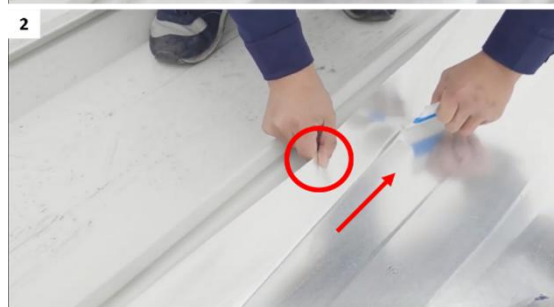
Rysunek (2-11) Montaż folii na krawędziach zagięć po obu stronach
