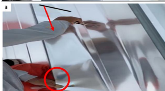
Rysunek (2-10) Montaż folii na płaskich powierzchniach
