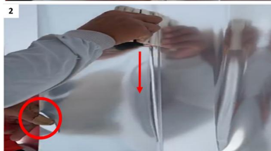
Rysunek (2-9) Montaż folii na zagięciu w części środkowej
