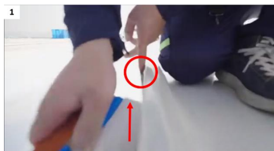
Rysunek (2-11) Montaż folii na krawędziach zagięć po obu stronach
