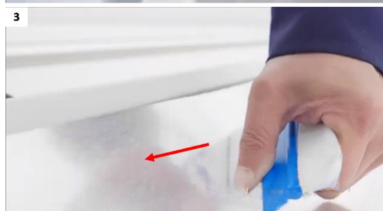
Rysunek (2-12) Montaż folii na powierzchniach nachylonych po obu stronach
