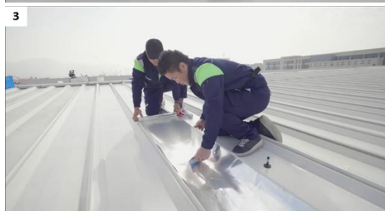
Rysunek (2-8) Przyklejanie i mocowanie części środkowej membrany
