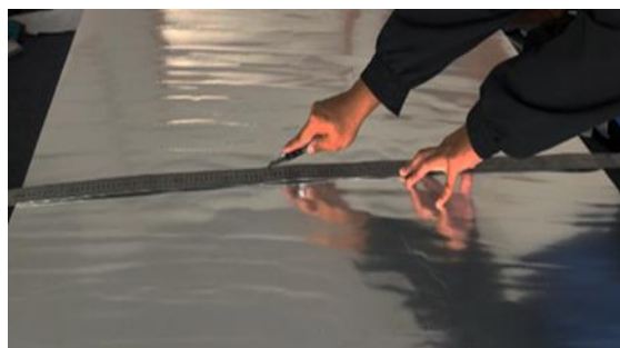
Rysunek (2-3) Proces cięcia membrany
