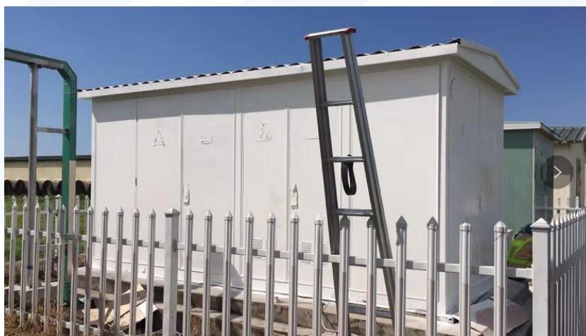
Rysunek 2-5. Zastosowanie powłoki chłodzącej radiacyjnie na zewnętrznej szafie elektrycznej w Xi'an
