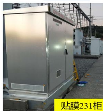
Rysunek 2-7. Zewnętrzna szafa elektryczna przed zastosowaniem folii chłodzącej radiacyjnie i pokryta folią.
